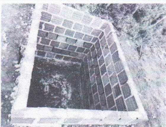
FOTO 6: EXECUÇÃO DA FOSSA SÉPTICA;
