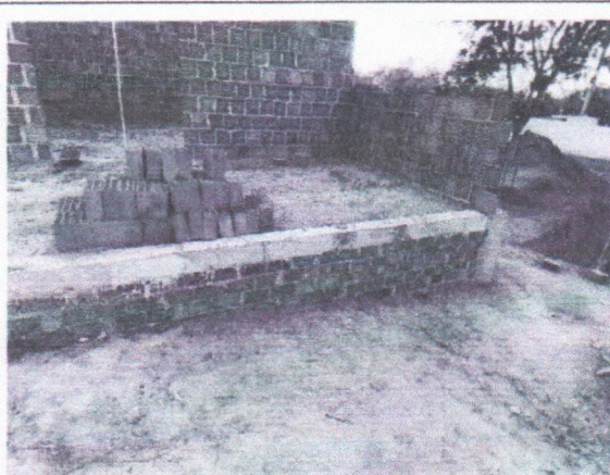
FOTO 2: EXECUÇÃO DO VELATÓRIO;
