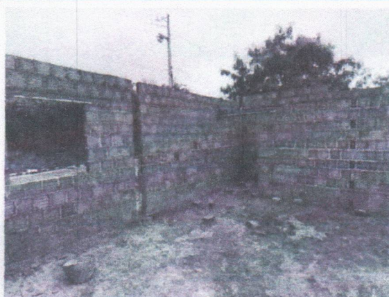
FOTO 5: EXECUÇÃO DO VELATÓRIO;
